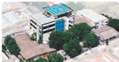
Vista aérea de unidade industrial
